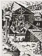
4. Macchinario che veniva in uso nella macinazione del grano con l'abburattamento meccanico della farina greggia con frullone a manovella (Giovanni Agostini, "L'arte di abburattare", Parigi 1784).
